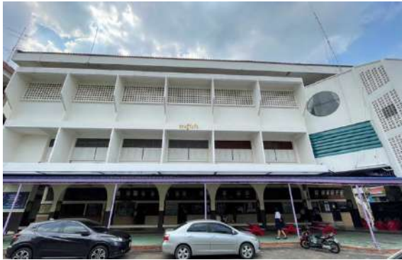
อาคาร 3 อาคารสฤณีวันรัต เป็นอาคาร 3 ชั้น โรงยิมพลศึกษา ธนาคารโรงเรียน
