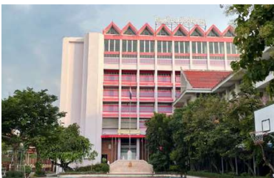
อาคาร 1 อาคารปฐมเทพมุนีศรีราชรัตนนาถ เป็นอาคาร 8 ชั้น และห้องปฏิบัติการ ห้องประชุม
